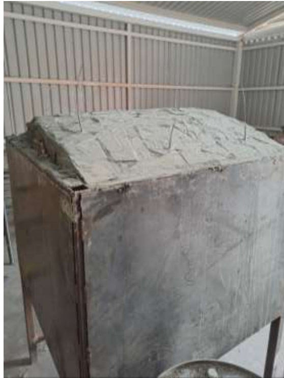
Figura 39. Vista de la cúpula concluida.
