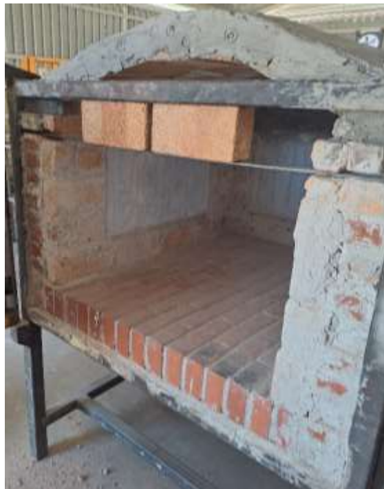
Figura 40. Cobertura de los espacios de la cúpula.
