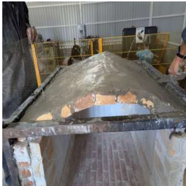
Figura 36. Primera capa de nivelación con mortero sobre la cúpula.
