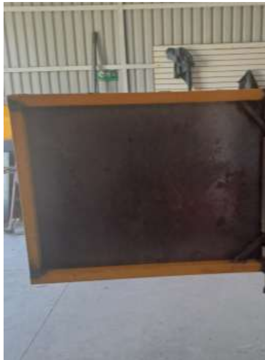
Figura 44. Estructura de la puerta con placa y refuerzos ya soldados.
