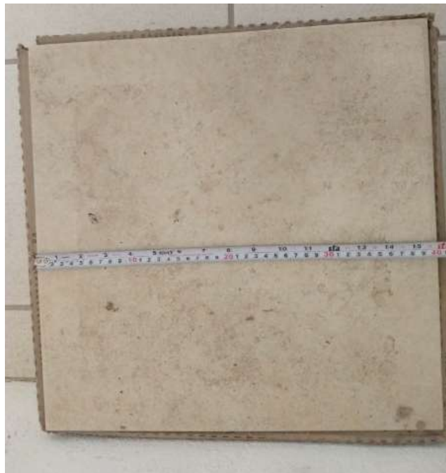
Figura 21. Aspecto del piso cerámico de capa aislante primaria.
