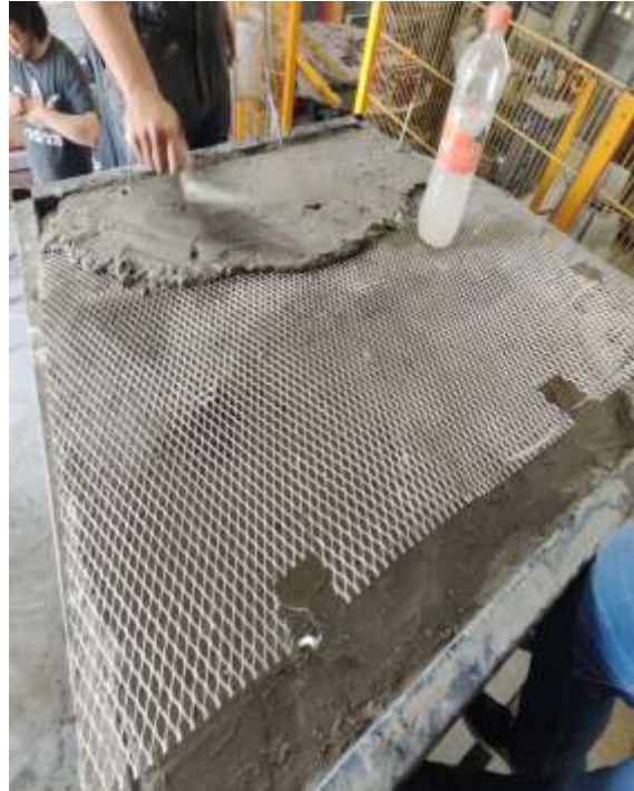
Figura 37. Segunda capa de mortero con malla de metal desplegado sobre la cúpula.
