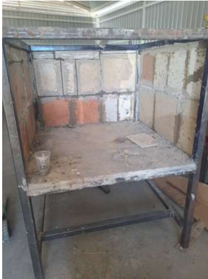
Figura 30. Recubrimiento del piso y paredes interiores con piso cerámico.
