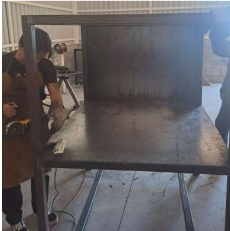
Figura 25. Vista del módulo de recubrimiento externo de seguridad a base de placa de acero unidas a la estructura.
