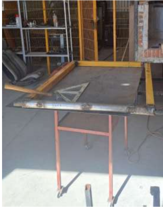
Figura 41. Construcción del marco de la puerta.
