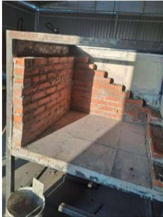
Figura 31. Recubrimiento parcial de paredes con ladrillo refractario M-25.
