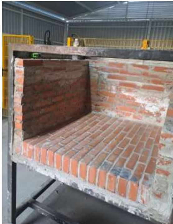
Figura 32. Colocación completa del ladrillo refractario M-25.
