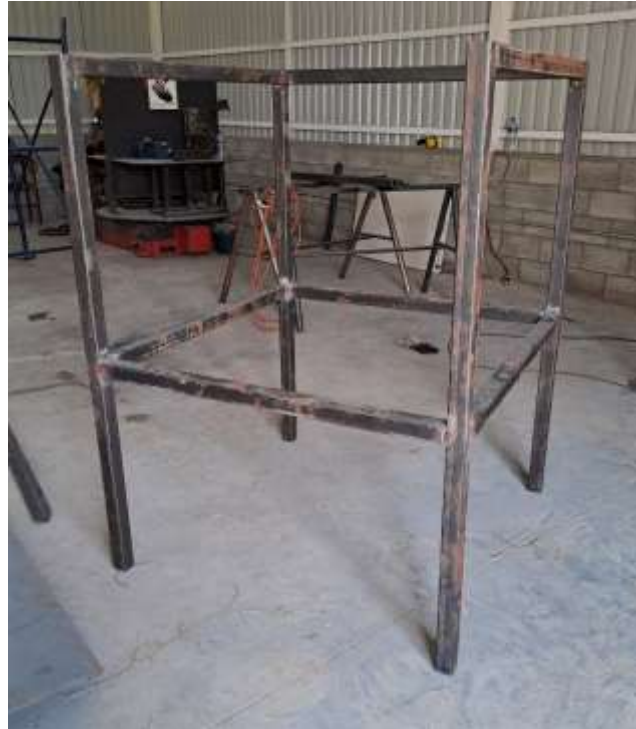
Figura 23. Armado inicial de la estructura de soporte con geometría tipo caja.
