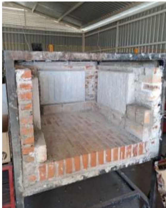
Figura 34. Colocación de placas de fibra cerámica con resistencias eléctricas.
