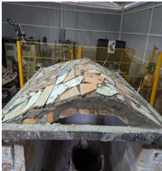
Figura 38. Última capa recubriendo con piso cerámico y afinando detalles con mortero.
