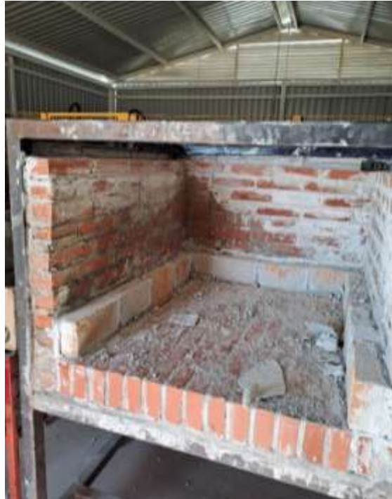
Figura 33. Recubrimiento inicial de paredes con ladrillo refractario K32.
