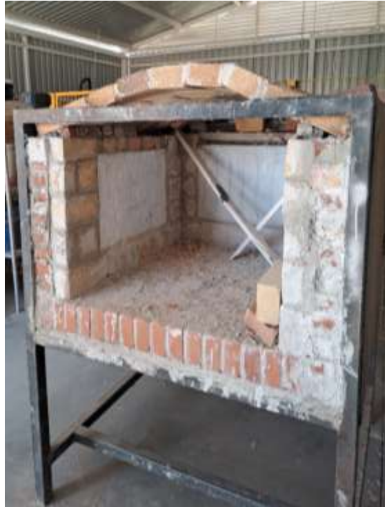
Figura 35. Construcción inicial de la cúpula.
